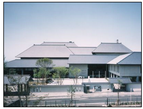
多賀城市文化センター
